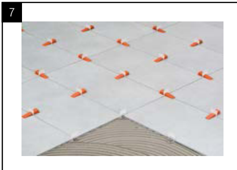
7. SISTEMA DI LIVELLAMENTO DELLE SUPERFICI
